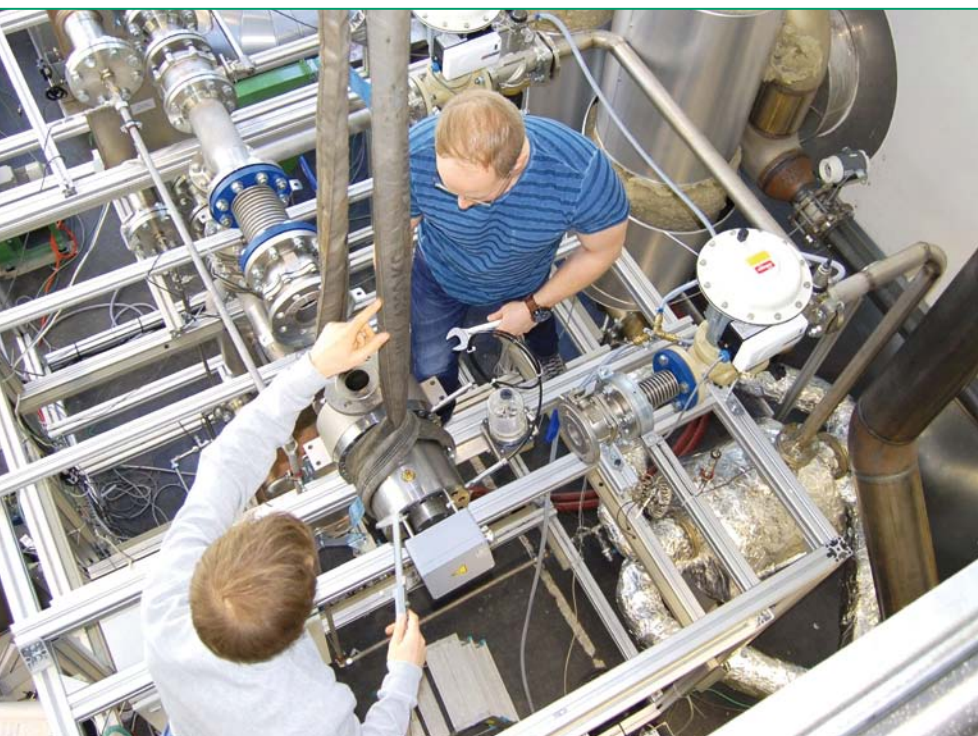
■ Abb. 5: Im Forschungskraftwerk des Zentrums für Energietechnik (ZET) der Universität Bayreuth wird eine kleine Turbine für die Stromerzeugung aus industrieller Abwärme installiert. Mit einem neuartigen Arbeitsfluid konnte ein Spitzenwirkungsgrad von nahezu 75 Prozent erzielt werden (Foto: Christian Wißler).
