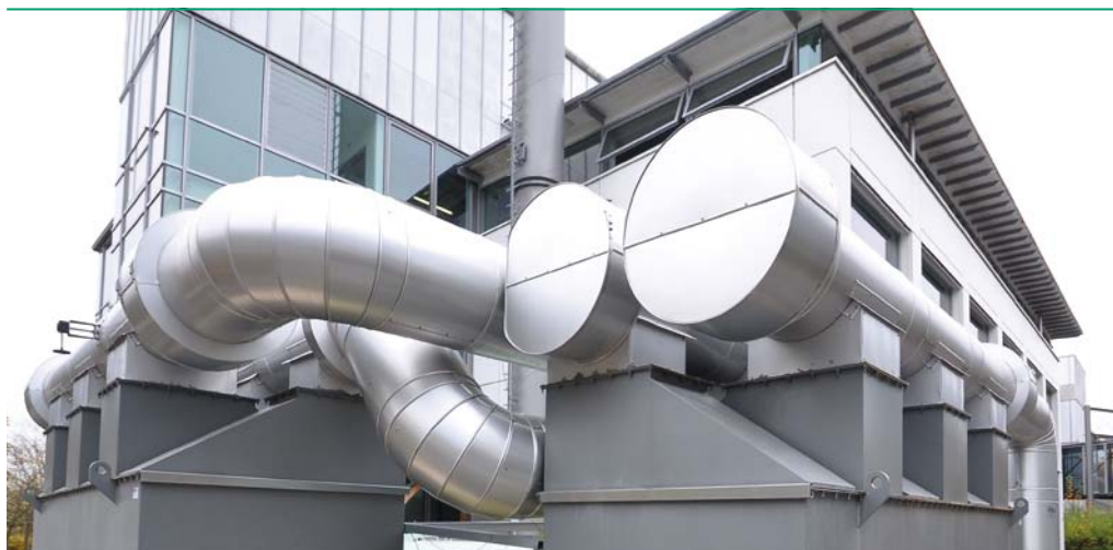
■ Abb. 4: Für Temperaturen bis 600 Grad Celsius einsetzbarer thermischer Speicher mit Sand als Speichermaterial. Der Speicher ist eingebunden in ein Forschungskraftwerk auf dem Campus der Universität Bayreuth (Foto: Andreas Obermeier).
